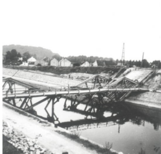
A4077-026-Brücke von Canne
