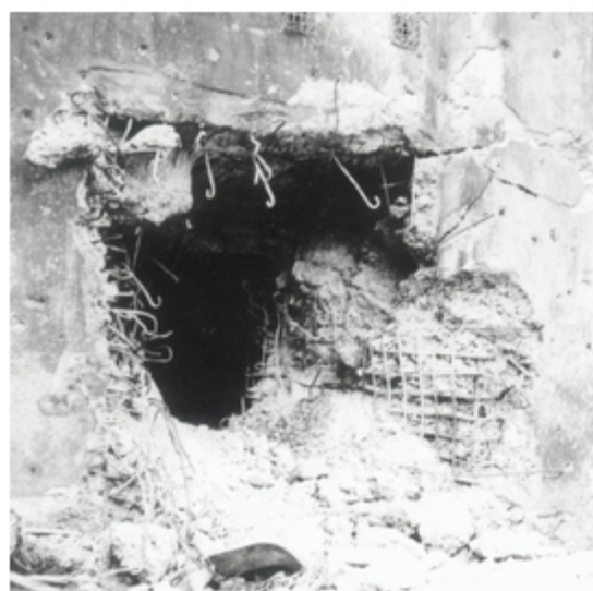
A4077-043-Eben Emael - Zerstörung bei Werk 1
