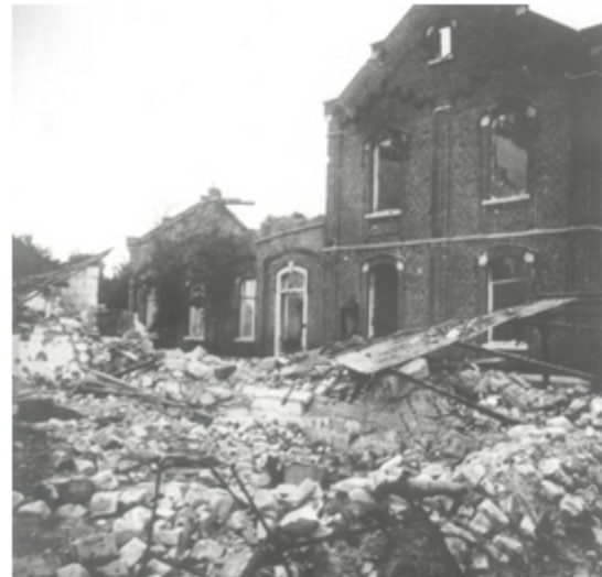
A4077-027-zerstörte Häuser bei Eben Emael
