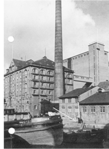
Holzsägmühle von der Wasserseite gesehen
